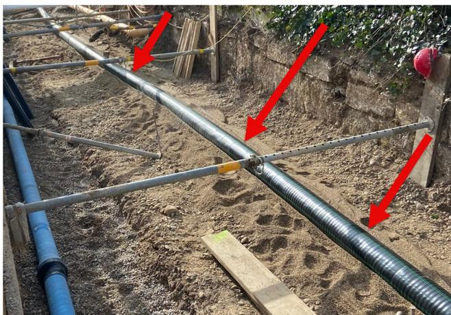
Im Bereich der Hausanschlüsse wird ein Standard-T-Stück (Abzweiger) eingebaut, verschweisst und anschliessend wieder wirksam isoliert.
